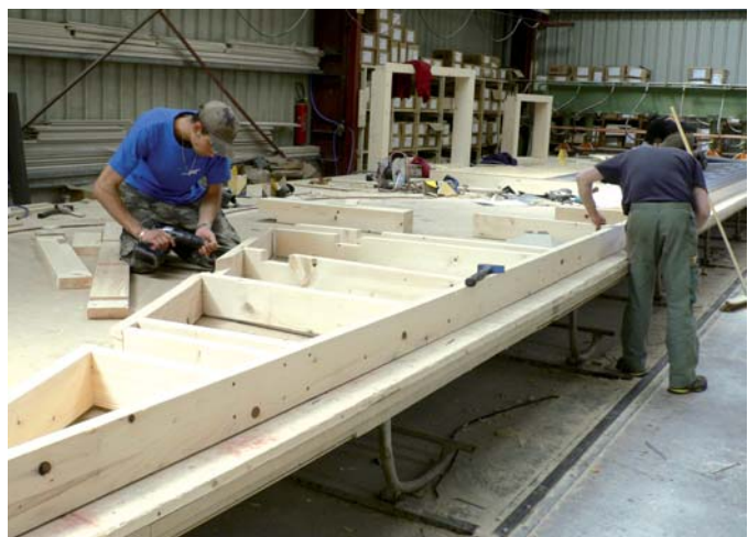
L'atelier d'assemblage où sont réalisés les éléments d'ossature et de charpente.
